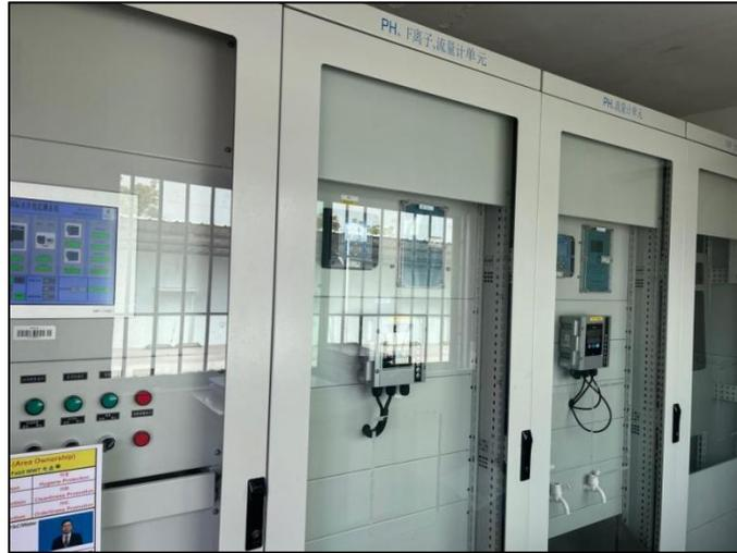
图 3-10 现场废水在线监测仪器
